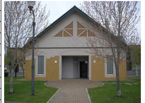
旭神中央公園トイレ
